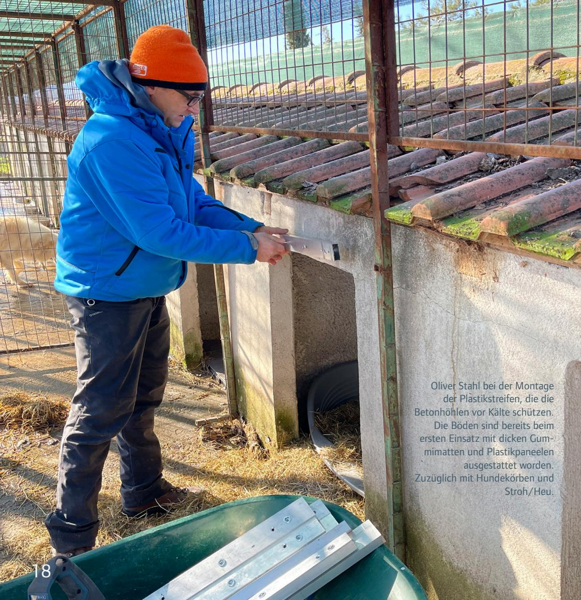
Oliver Stahl bei der Montage der Plastikstreifen, die die Betonhöhlen vor Kälte schützen. Die Böden sind bereits beim ersten Einsatz mit dicken Gummimatten und Plastikpaneelen ausgestattet worden. Zuzüglich mit Hundekörben und Stroh/Heu.
