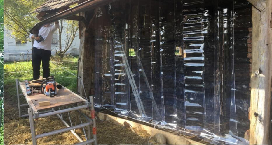
Eine Woche später: Das Dach ist neu gedeckt, die Scheune angehoben und mit neuen Fundamenten versehen, neu verkleidet und und und. Bei einem zweiten Einsatz im September wurde noch der Elektroanschluss fertiggestellt, die Bodenplatte in Stall und Heulager betoniert, der Lamellenvorhang angebracht und und und ...
